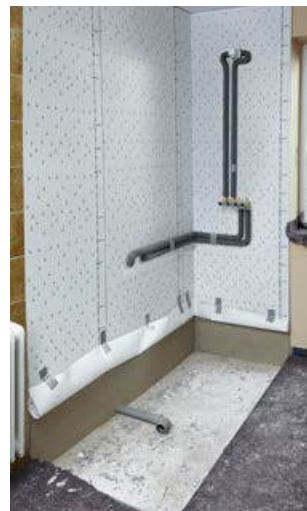
4. Leitungen installieren ggf. versetzen
