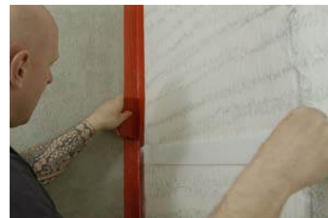
3. Eckdichtbänder anbringen
