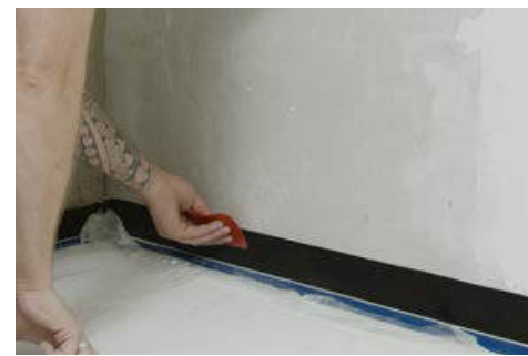
1. Wannendichtband verkleben
