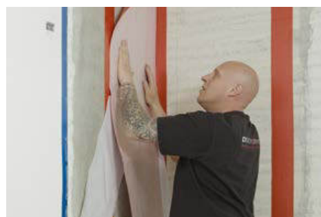
4. Dichtbahnen anbringen
