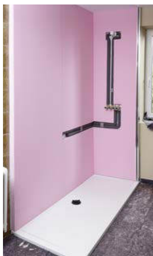
6. Nur bei versetzten Leitungen: Trägerplatte anpassen und anbringen
