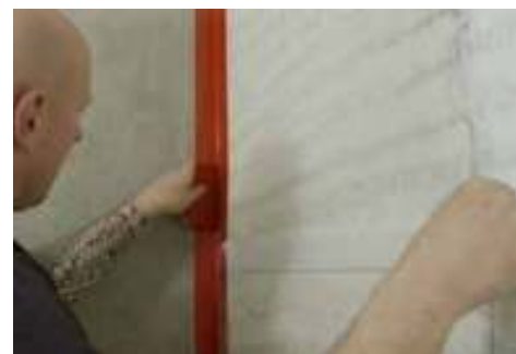
3. Eckdichtbänder anbringen
