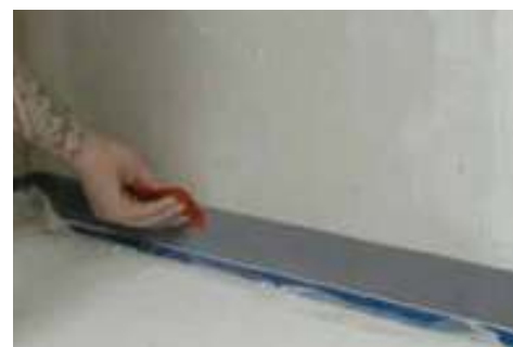
1. Wannendichtband verkleben
