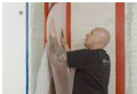
4. Dichtbahnen anbringen
